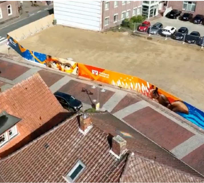
Platz für was Neues. In den nächsten Monaten entsteht hier sukzessiv die neue Hauptstelle.
